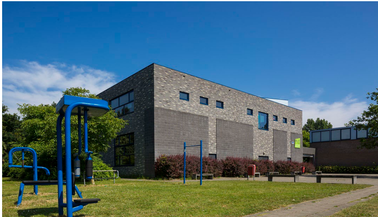
Locatie J.S. Bachweg
